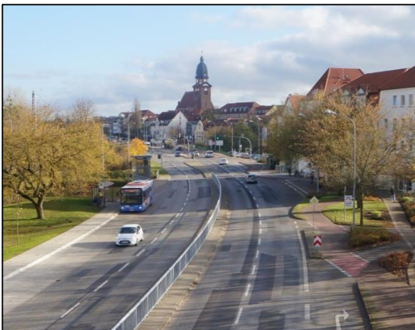
Abb. 19 Konfliktbereich B 192 – Schweriner Damm
