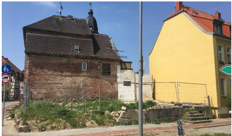
Große Burgstraße 10 (nach dem Abriss 2017)
