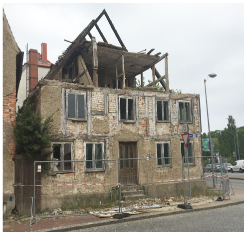
Große Burgstraße 10 (vor dem Abriss)
