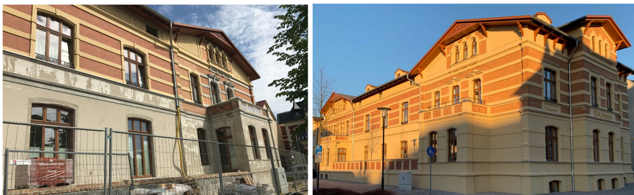
Bahnhofstraße 20 während der Sanierung 2017 und Fertigstellung 2018
