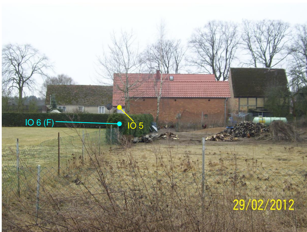
Bild 4: Wohngebäude Star sow 14 (Nordfassade, AWB)
