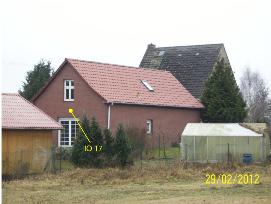
Bild 13: Wohngebäude Starsow 23b (Nordostfassade)
