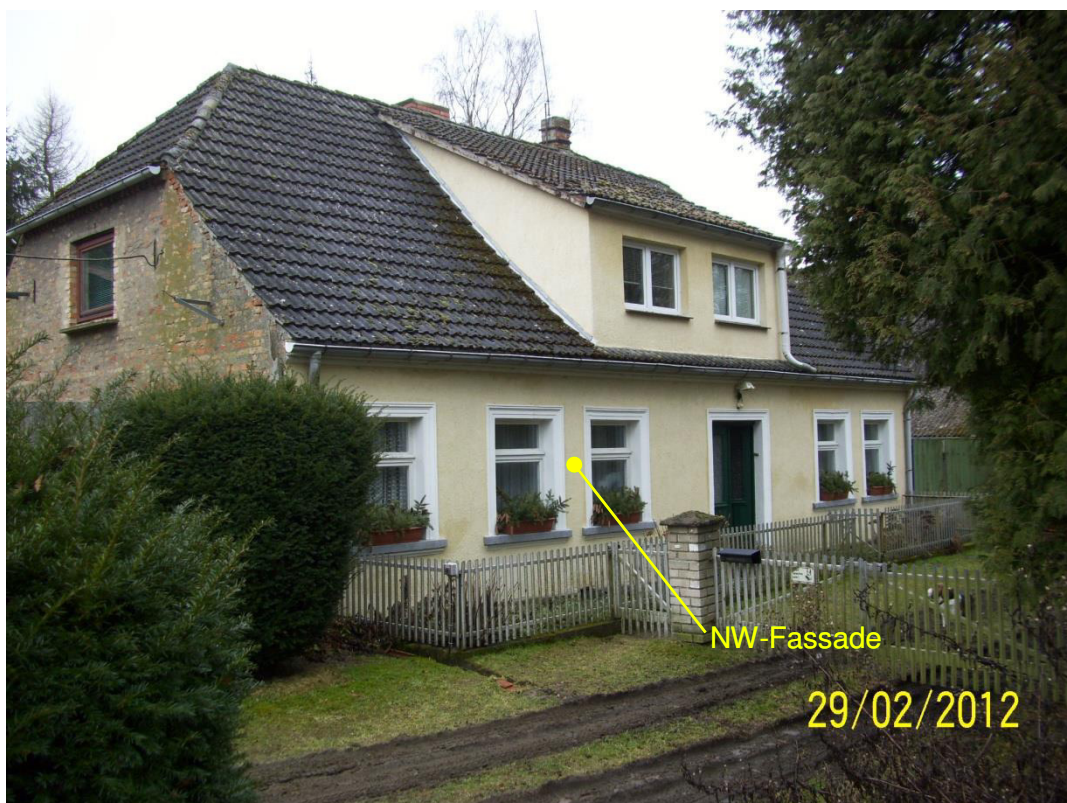
Bild 16: Wohngebäude Hohe Brücke (IO HB01, IO HB02)
