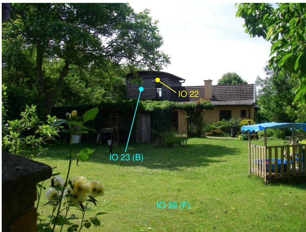
Bild 6: Wohngebäude Starsow 16 (Nordostfassade und Außenwohnbereiche)
