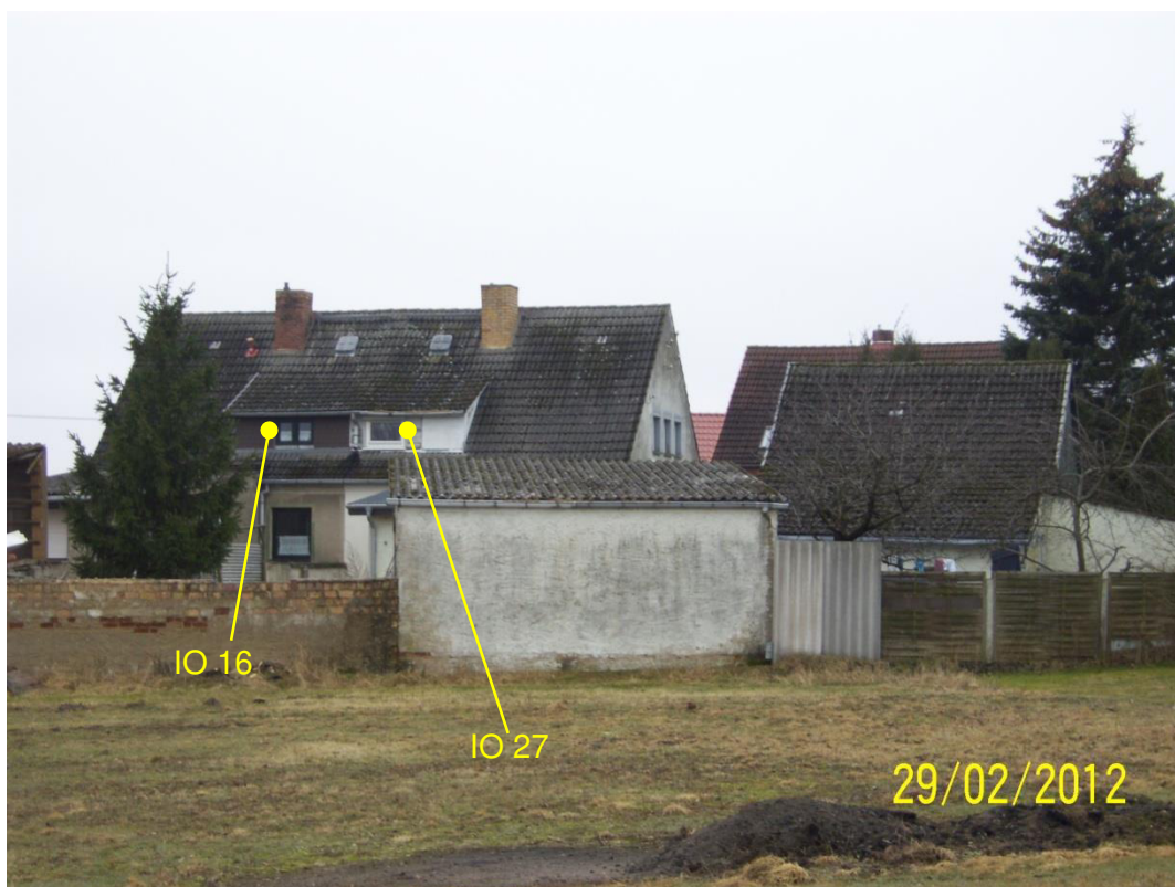
Bild 12: Wohngebäude Starow 23 und 22 (Nordostfassade)
