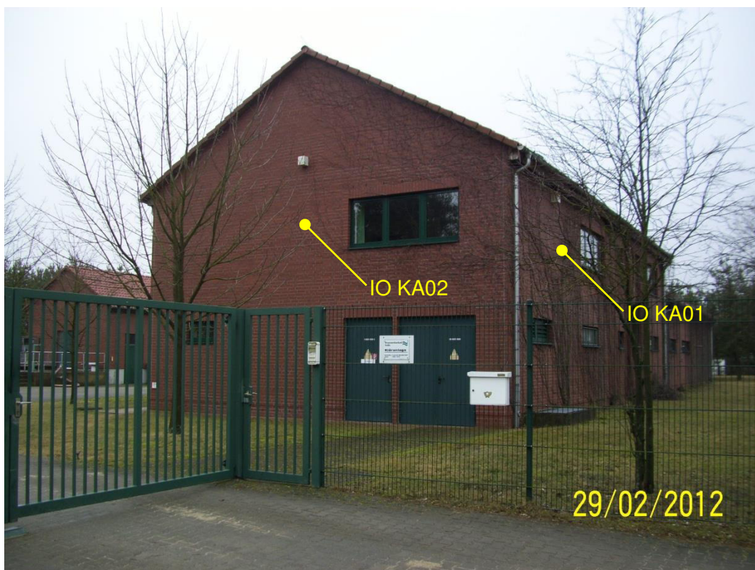
Bild 18: Verwaltungsgebäude Kläranlage (Südwest und Nordwestfassade)
