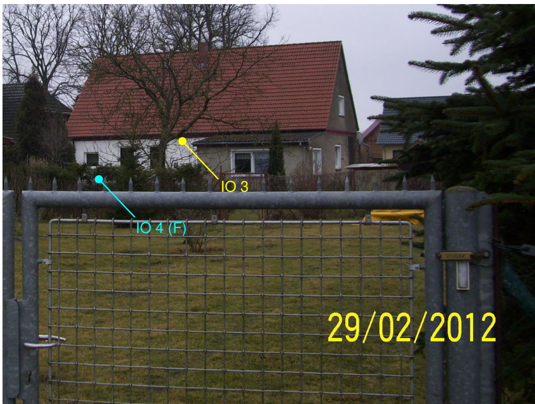
Bild 2: Wohngebäude Starsow 13 (Nordfassade, AWB)
