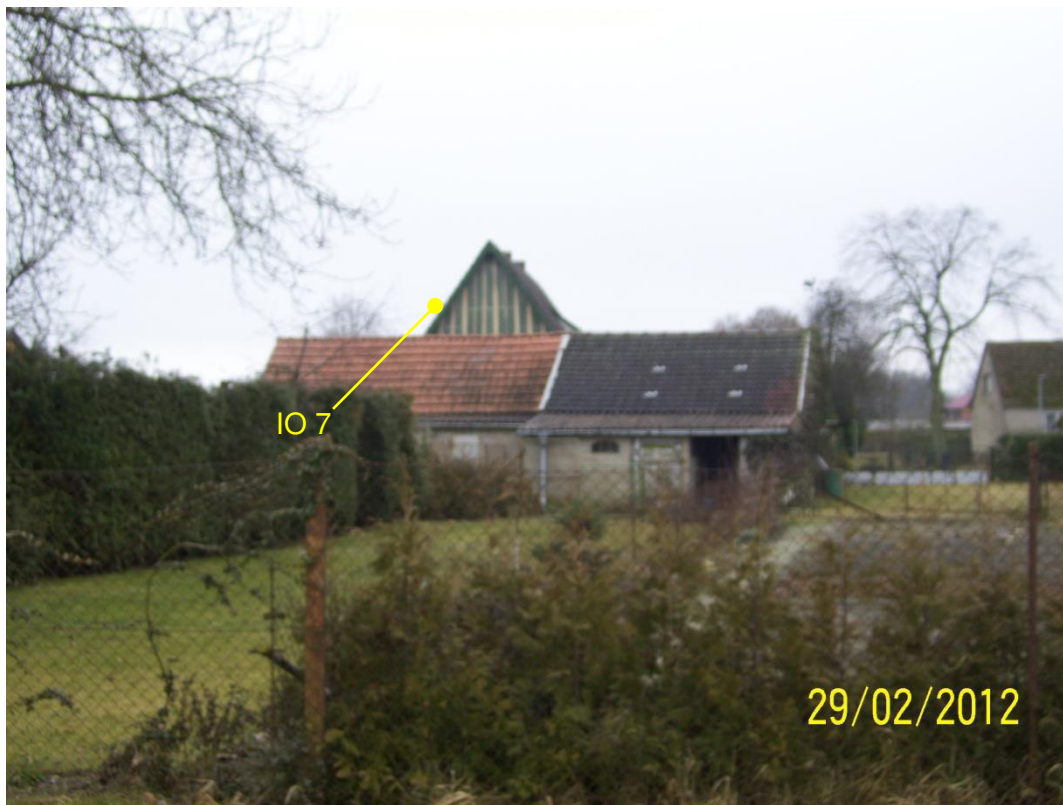
Bild 5: Wohngebäude Starsow 15 (Ostfassade)
