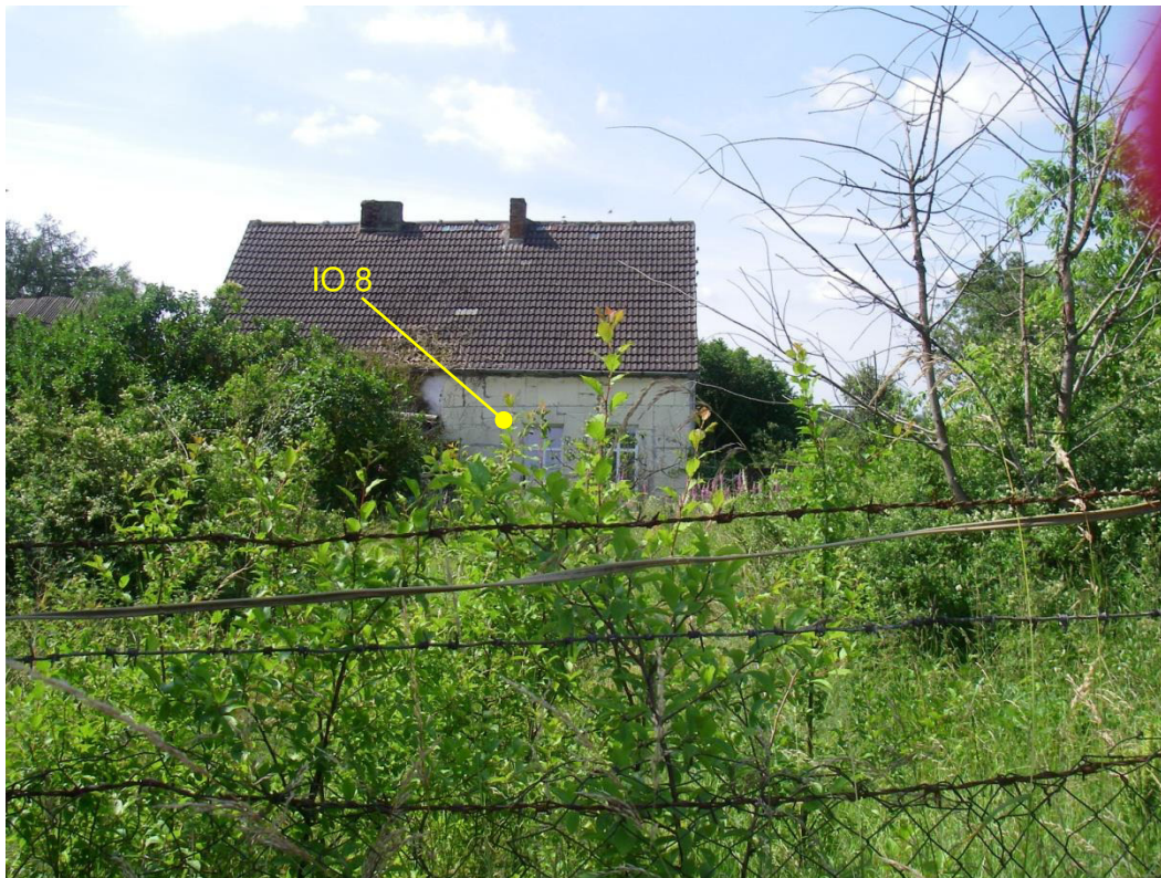
Bild 7: Wohngebäude Star sow 17 (Nordostfassade)
