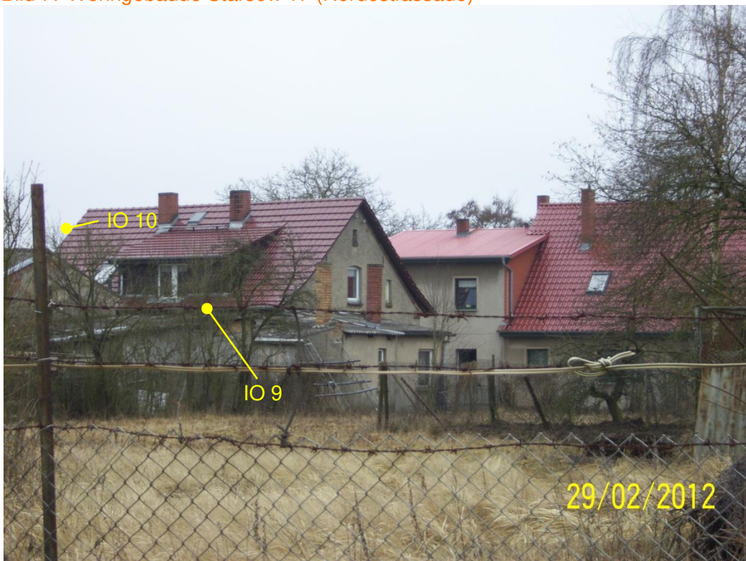
Bild 8: Wohngebäude Star sow 18 (Nordost- und Südostfassade)
